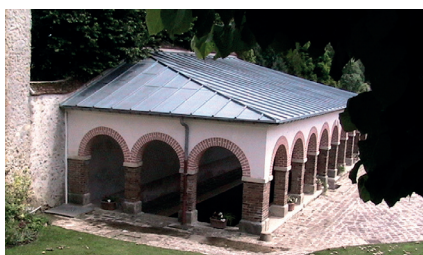
▲ Rénovation du lavoir de la commune, Ozouer-le-Voulgis
