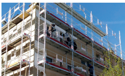
▲ Participation à la réhabilitation thermique de 140 logements, Le Bréau
